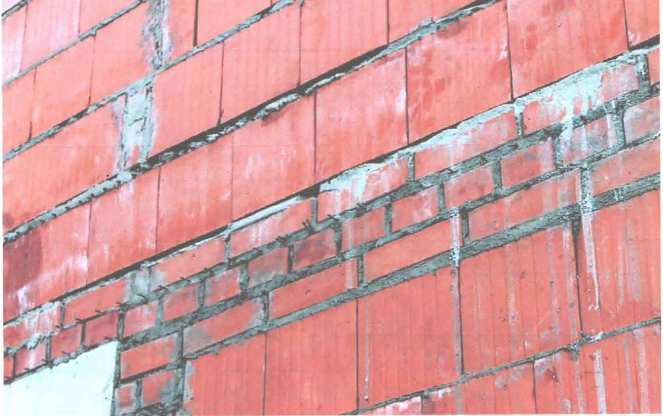
Фото-6: армирование кирпичного пояса под перекрытие дома
