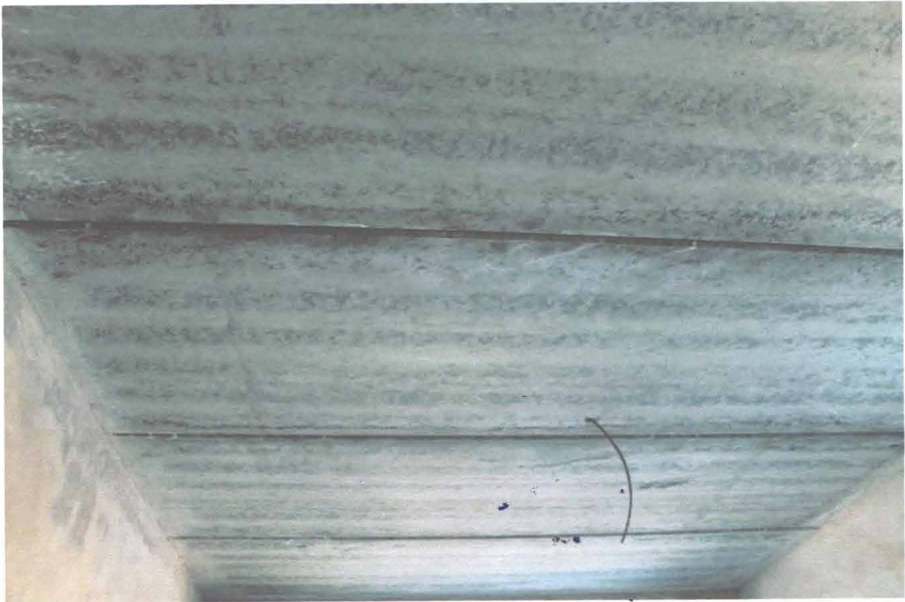
Фото-7: сборные межэтажные перекрытия
