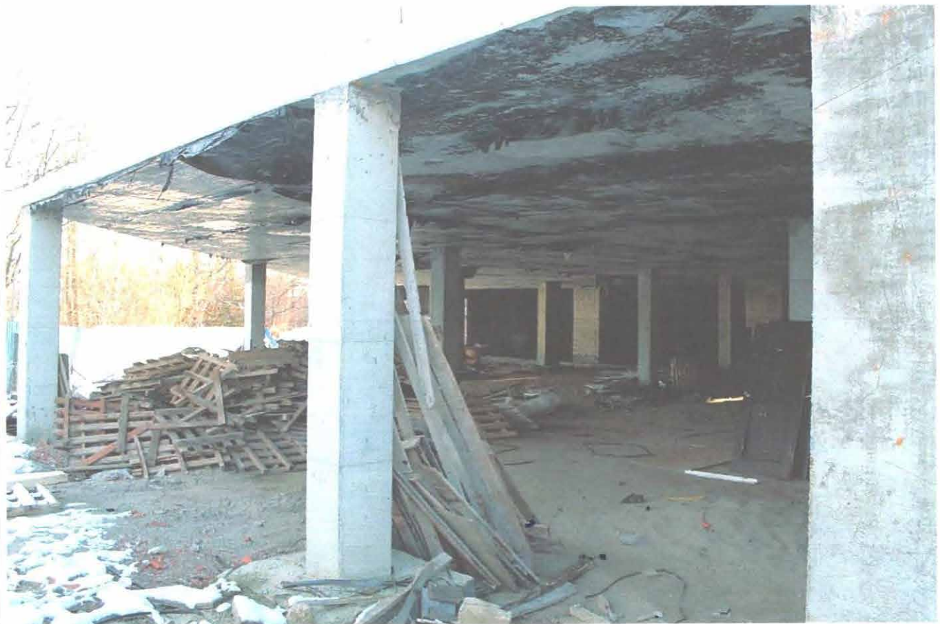
Фото-9: монолитная плита и колонны перекрытия над открытой автостоянкой
