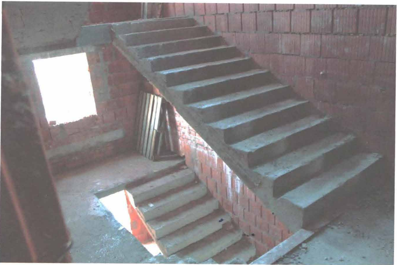
Фото-11: межэтажная лестница
