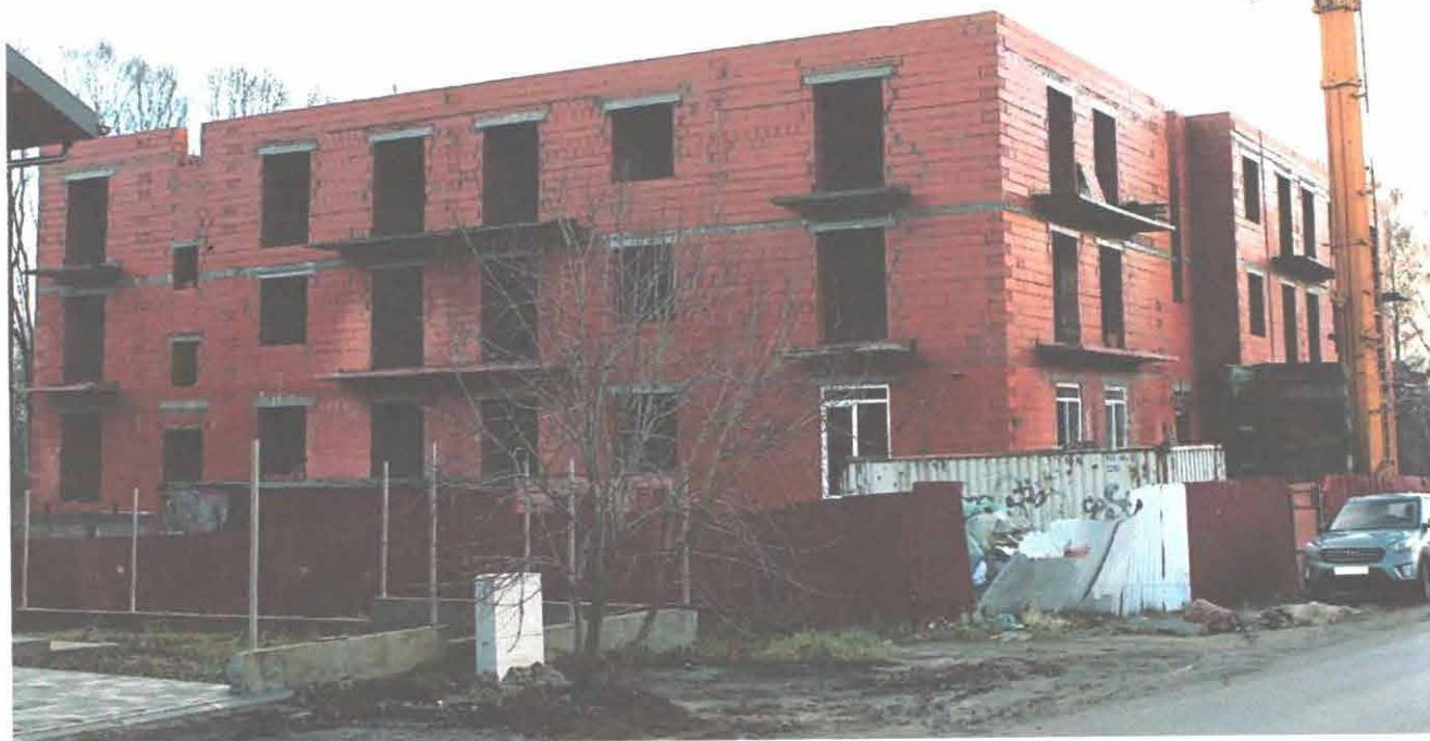
Фото-2: наружные стены дома
