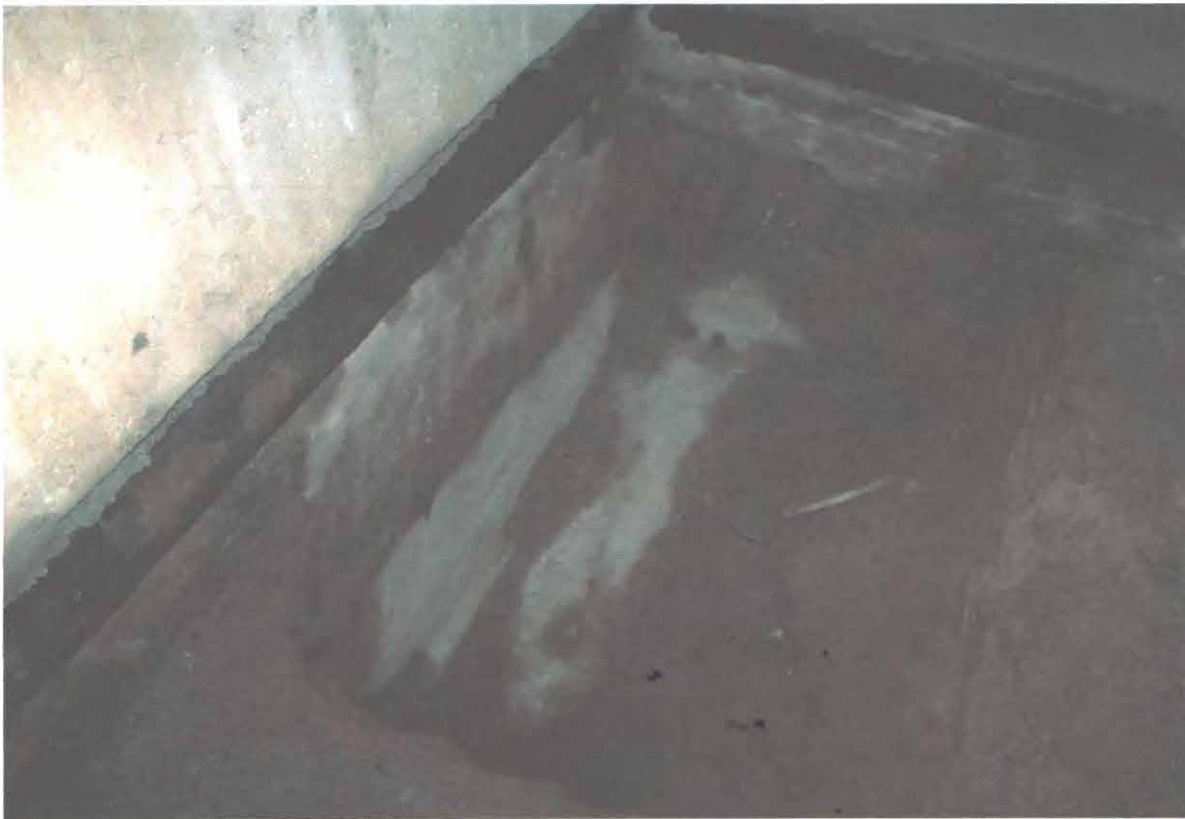
Шурф №1: сборный ленточный фундамент по оси 1
