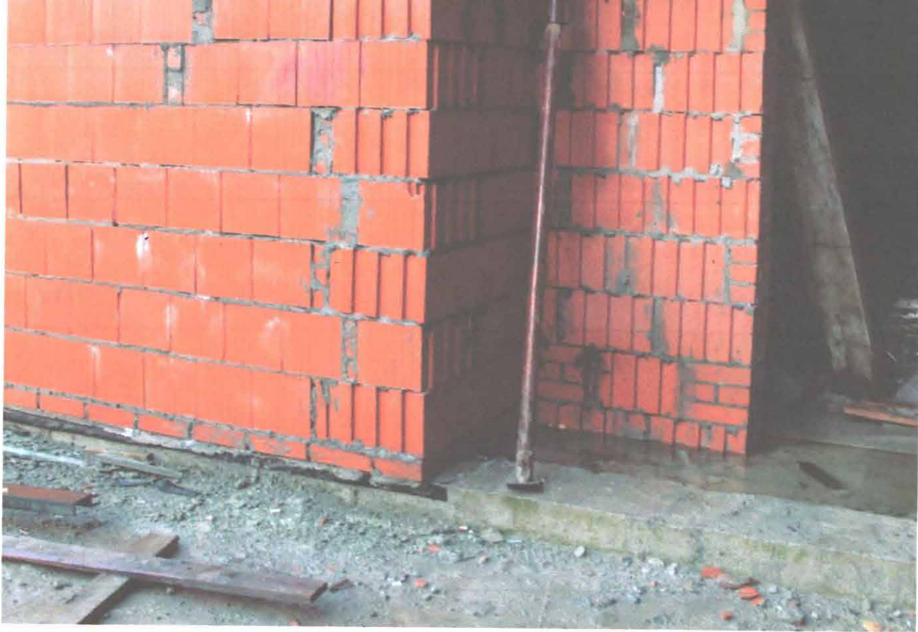
Фото-10: монолитная балка под опирание наружных стен по оси 2
