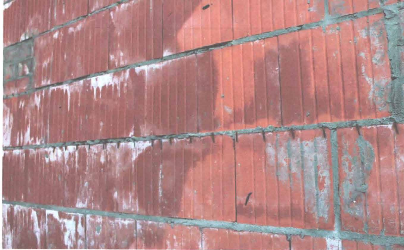
Фото-4: армирование кладки стен дома
