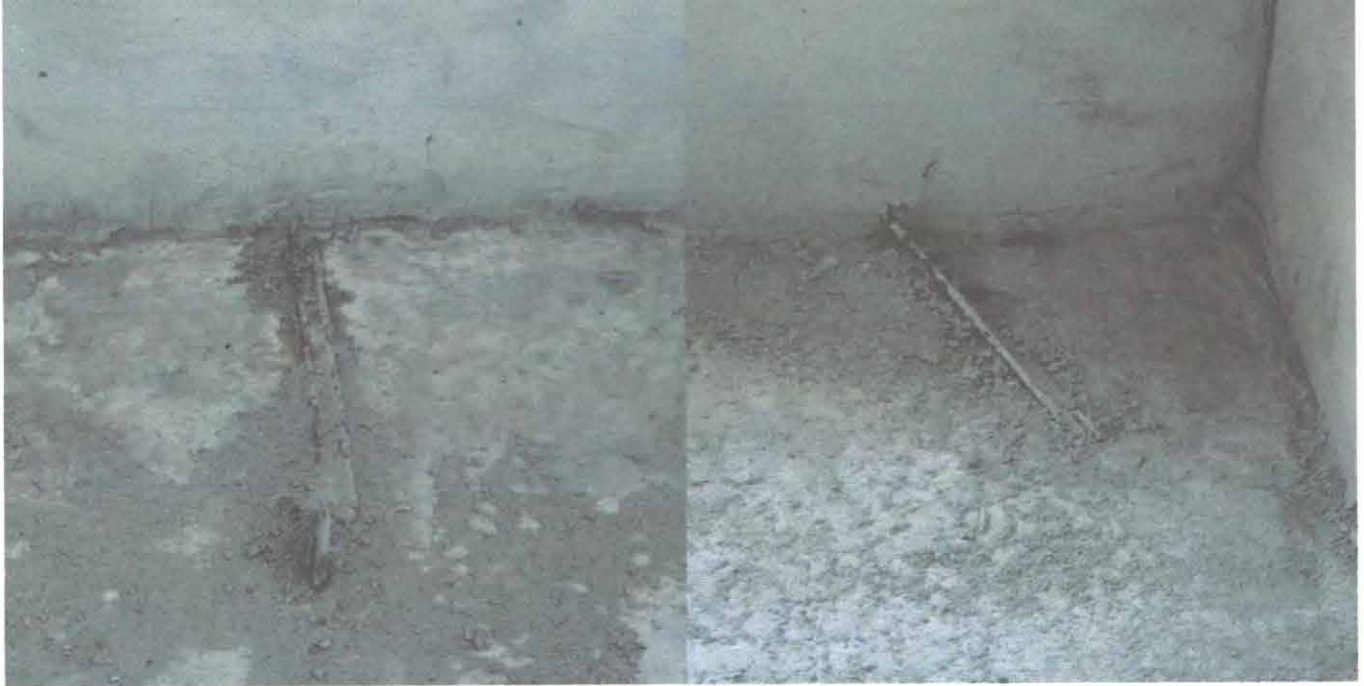
Фото-8: анкеровка сборных плит перекрытий
