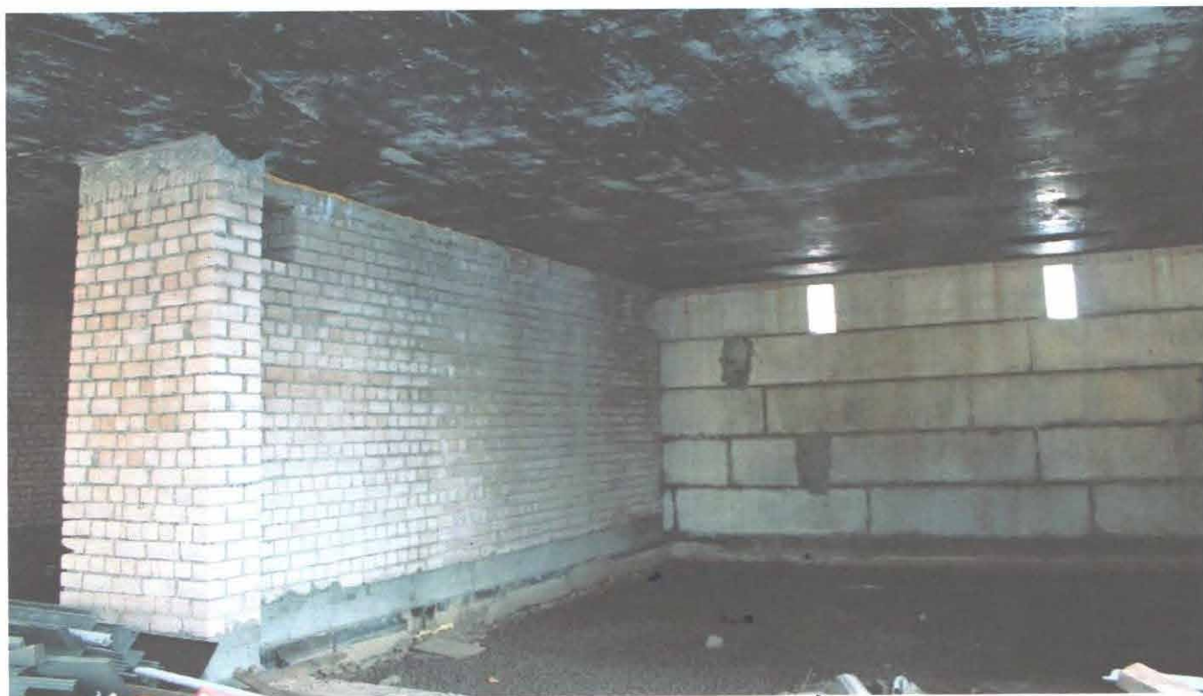
Фото-1: наружные и внутренние стены техподполья
