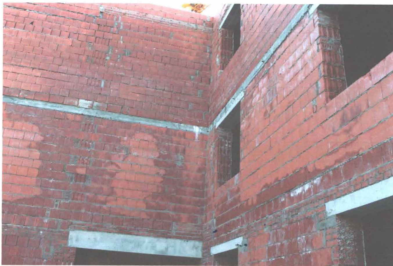
Фото-5: кирпичный и монолитный пояса под перекрытия дома
